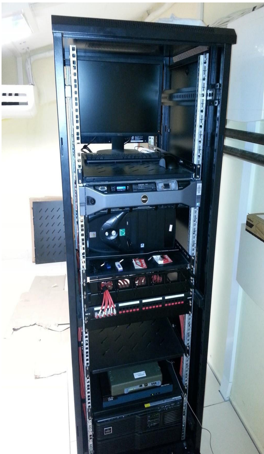
Figura 2.2: Exemplo de montagem rack fechado.
