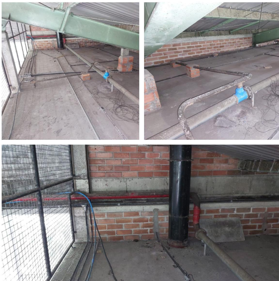
Figura 1 - Local onde será interligado tubulação nova
